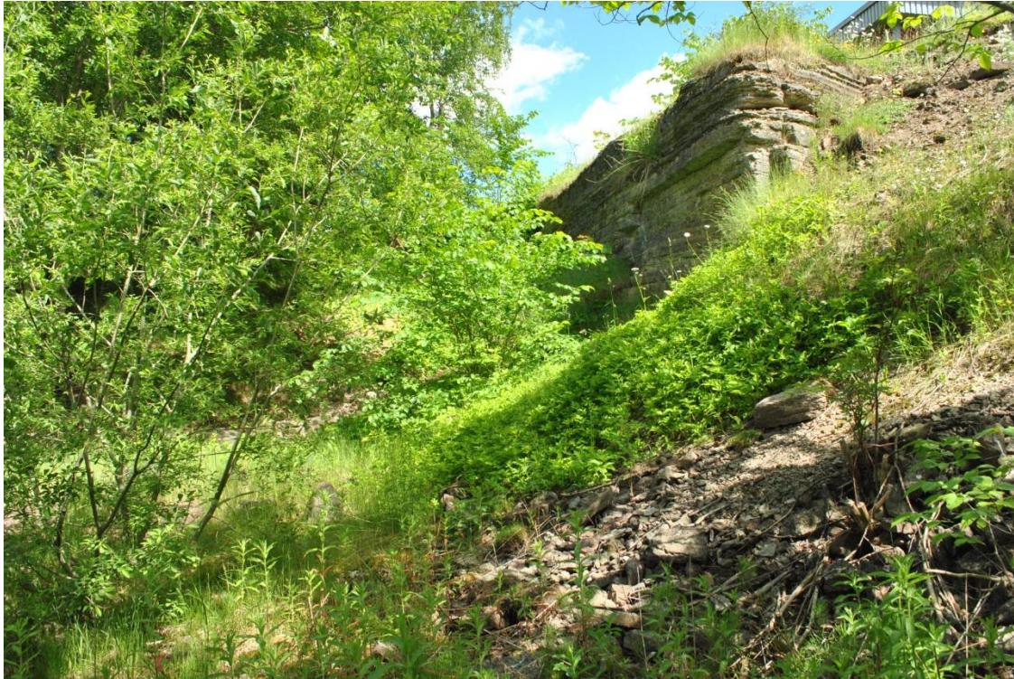
Figur 7. Objekt 3. Kalkbrottskanten och en rasbrant.
